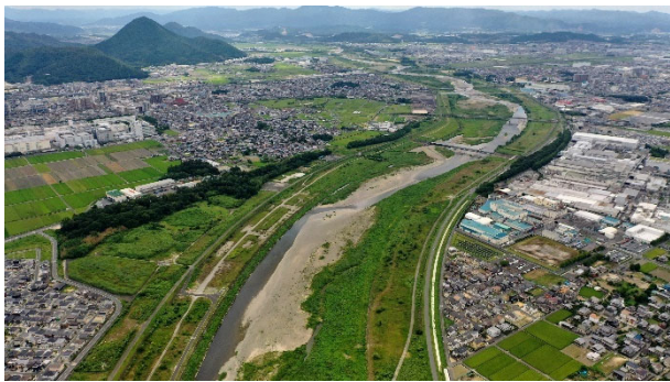
写真 1.7 野洲川 (6.0k 付近)
