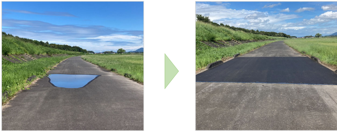
図 6.5 管理用通路舗装の補修
