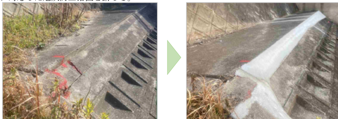
図 6.6 張りブロックの補修
