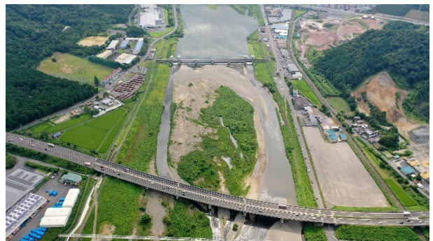
写真 1.10 野洲川 (13.0k 付近)
