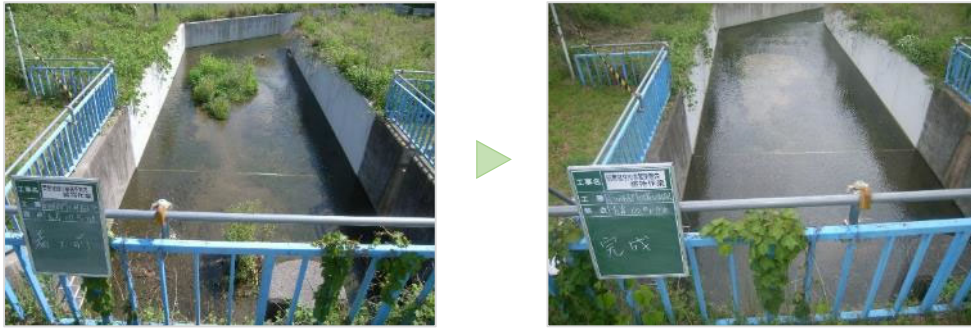
図 6.2 維持掘削状況
