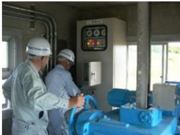
図 5.5 機械設備等の点検
