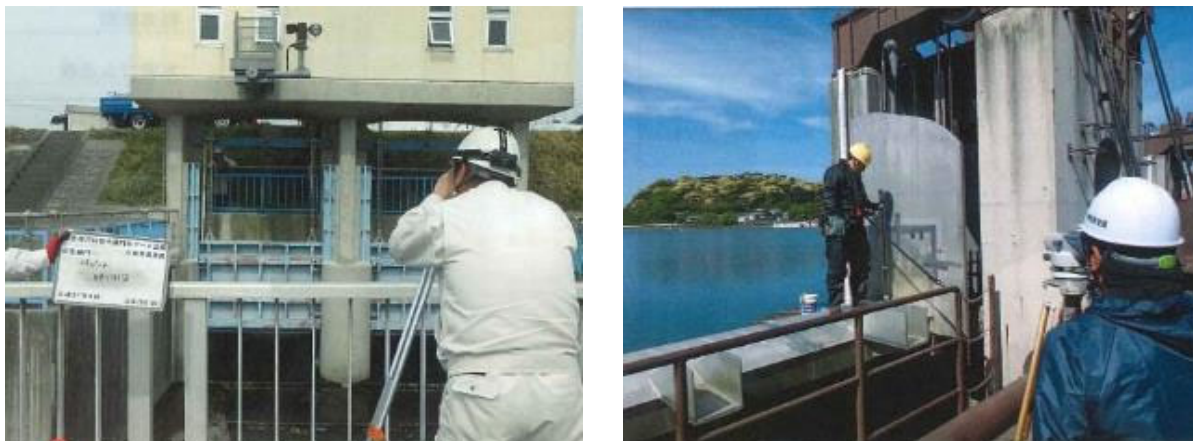
図 5.4 河川管理施設の点検
