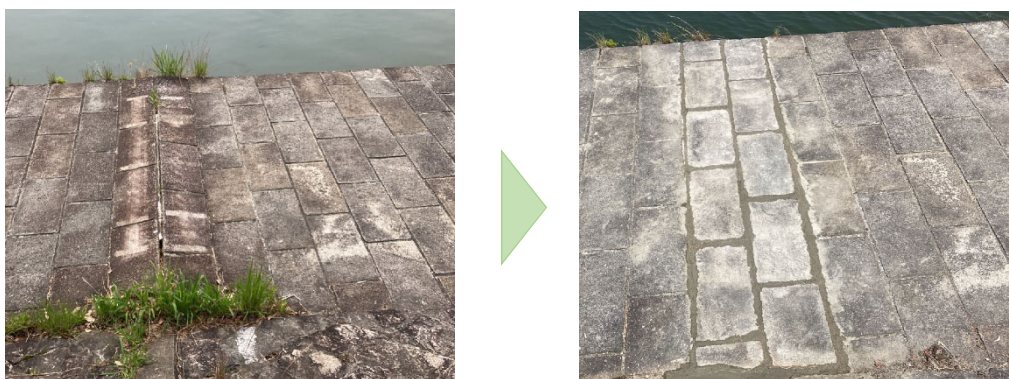
図 6.3 護岸天端の補修
