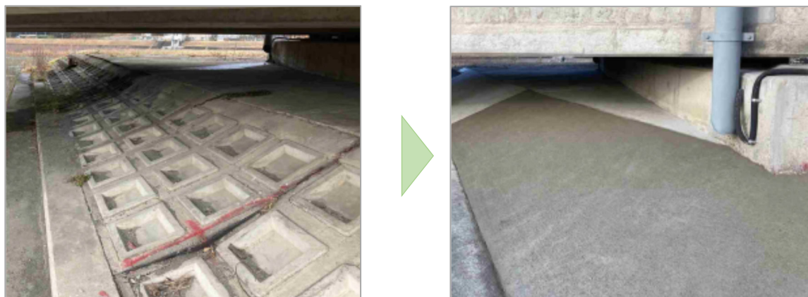
図 6.4 張りブロックの補修
