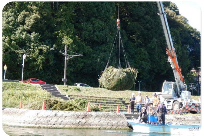
回収した水草の揚陸・仮置き作業（瀬田川右岸73.2k付近）
