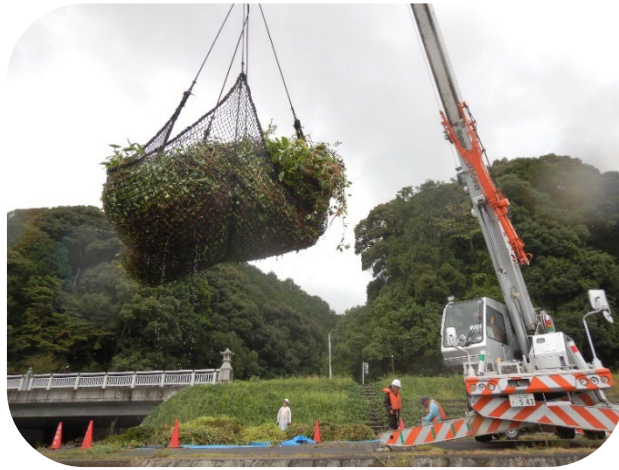
回収した水草の揚陸・仮置き作業（瀬田川右岸73.2k付近）
