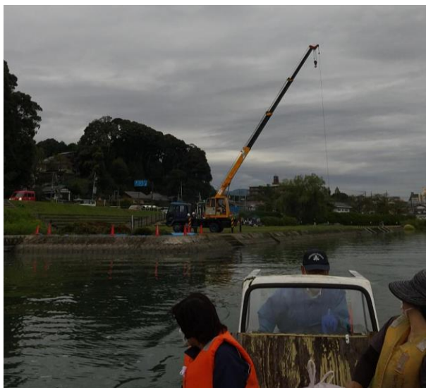
水草揚陸・仮置き場所（瀬田川左岸73.2k付近）
