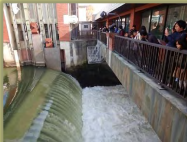
大迫力！バイパス水路
