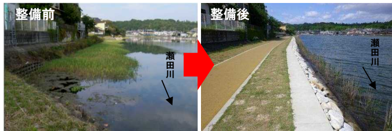
環境に配慮した護岸・管理用通路の整備前後
