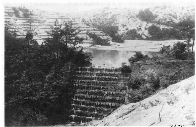
明治時代より効果を発揮する堰堤(鎧堰堤)
