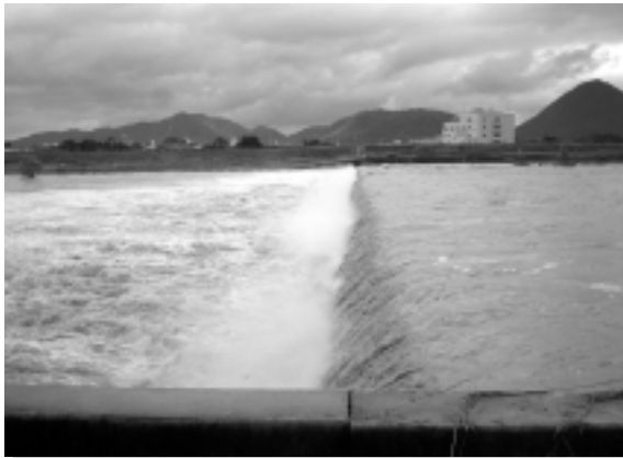
野洲川落差工付近
