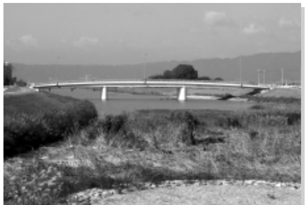
草津川(下流部)
