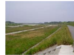
⑬計画箇所中間点より下流を望む
