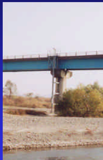
水質自動監視装置
