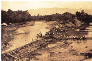
(昭和28年被災応急締切工事)
