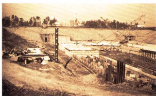
(野洲川放水路の工事風景)
