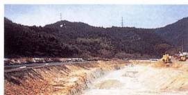
(洗堰下流域の工事風景)
