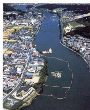
(洗堰上流域の工事風景)
