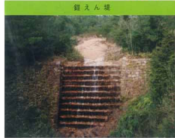
明治22年に完成した石積みのえん堤。田上山にはこのほかにも歴史的にも貴重なえん堤、谷止工がある。
