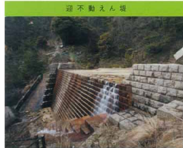
日本とオランダの交流400周年を記念してつくられた砂防えん堤(高さ9.0m 長さ34.0m)
