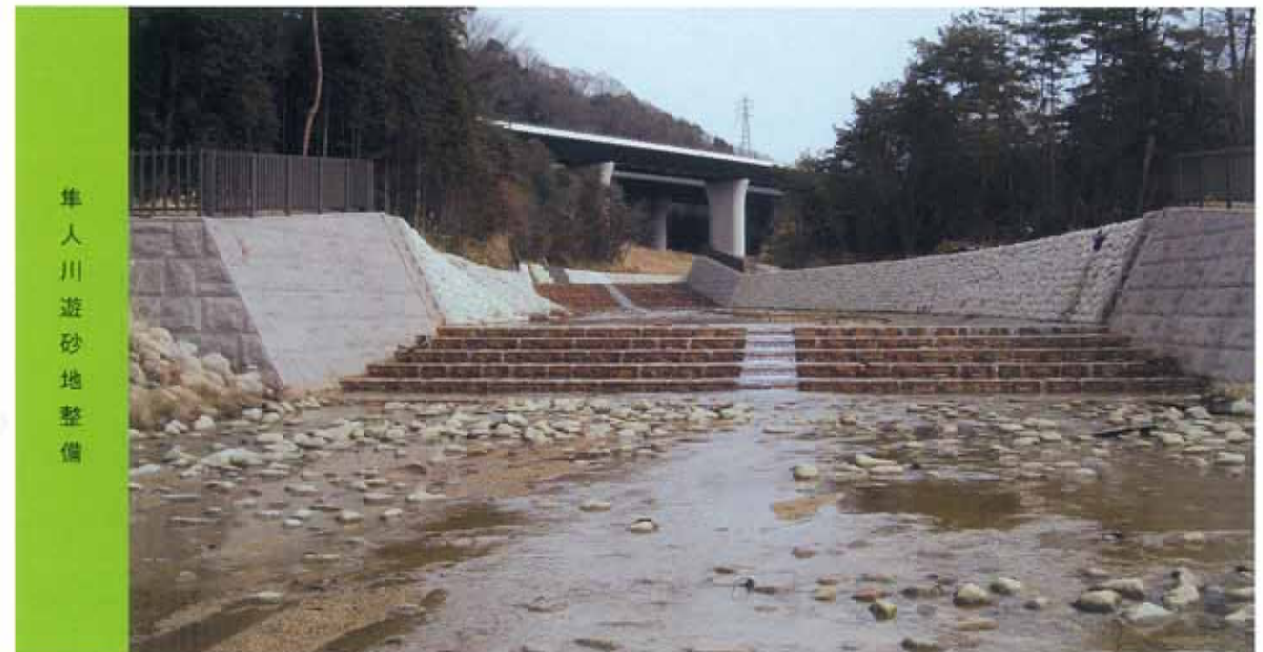
日本とオランダの交流400周年を記念してつくられた砂防えん堤(高さ9.0m 長さ34.0m)
