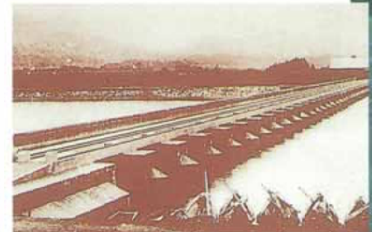
旧洗堰。現在は撤去され、その一部が残されている
