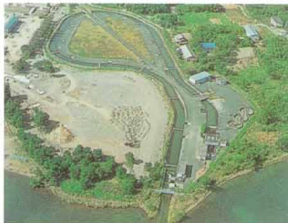
水産資源維持事業として、アユ苗育成のための人工河川を設置
