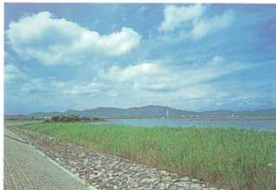
湖岸堤・管理用道路が通過するヨシ地帯は、植栽によって復元
