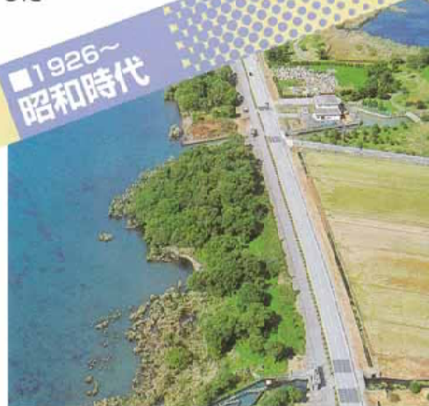
▲浸水を防ぐために整備された湖岸堤・管理用道路
