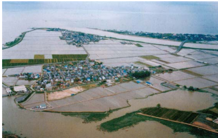
琵琶湖沿岸での浸水被害の状況 (H7.5撮影)
