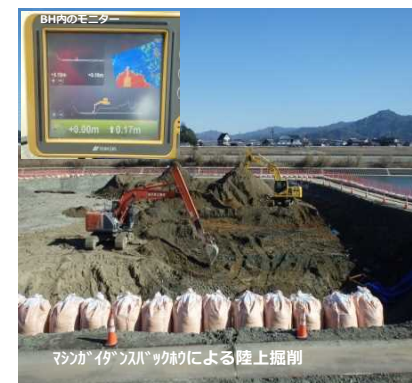
ICT建機による施行状況
