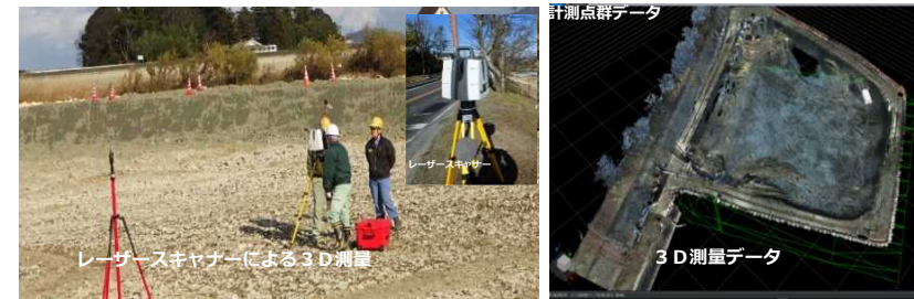
ICT起工測量（レーザー・スキャナー）
