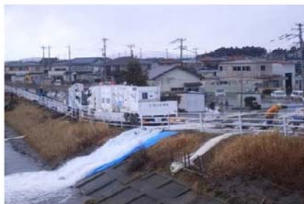
東日本大震災復旧支援(排水作業) (H23.3~H23.5)
