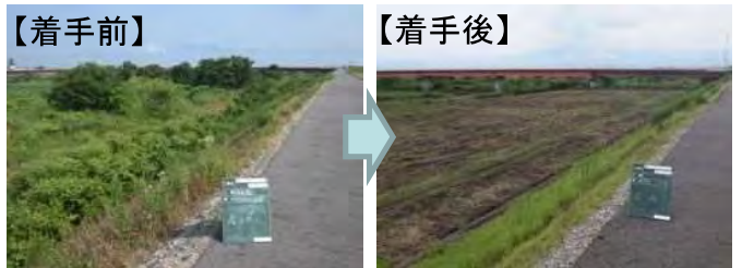
守山市服部町地先 【河道内樹木伐採状況】
