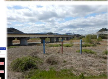
危機管理型水位計 (野洲川13.2k右岸)
