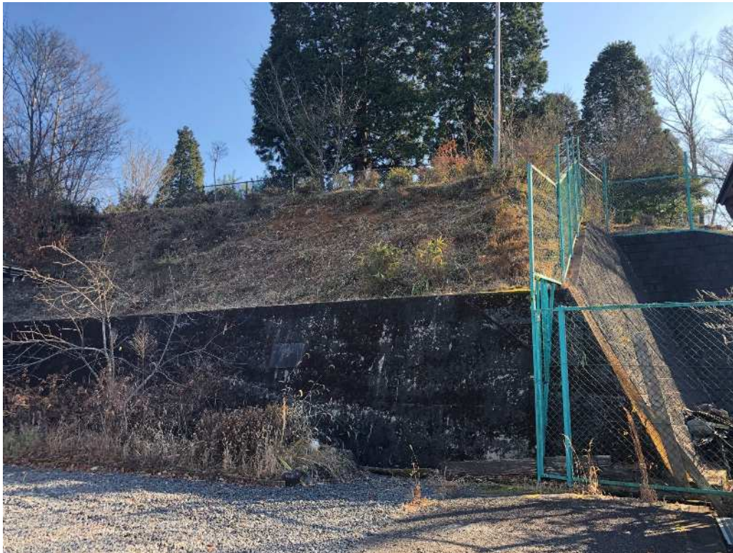
図 8 信楽中学校南側のがけ崩れ箇所に整備されたコンクリート擁壁
