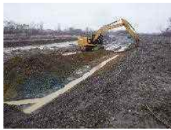
河道掘削 (石狩川水系、北海道開発局)
