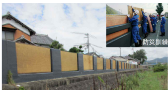
自主防災活動による量堤設置 (揖保川水系、たつの市)
