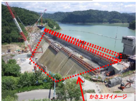
ダム建設・ダム再生
