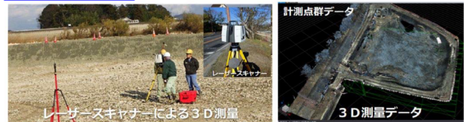
ICT起工測量 (レーザーメスキャナ)
