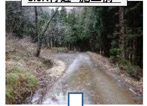
8.6K付近 施工前
