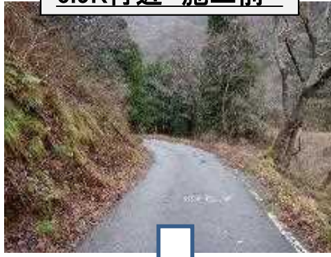
6.9K付近 施工前
