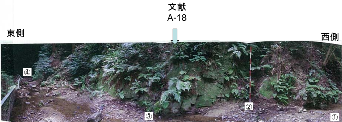
写真 参考資料4-1.7 本流左岸, 文献A-18通過部付近
