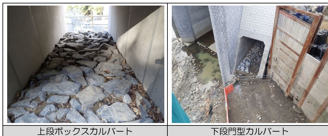
写真 4.1-4 岩盤河床の創出状況（2023年1月）
