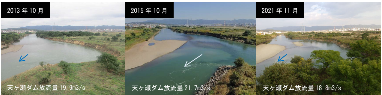
巨椋大橋上流の河道の状況
