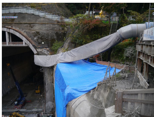
写真 4.1-2 養生シートでの湿岩面防護状況（2020年12月）
