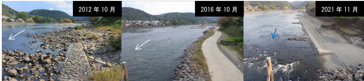
宇治橋上流左岸の護岸状況
