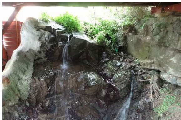
写真 4.1-1 湿岩面への給水実施状況（2017年7月）
