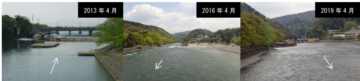
塔の島周辺の工事実施状況
