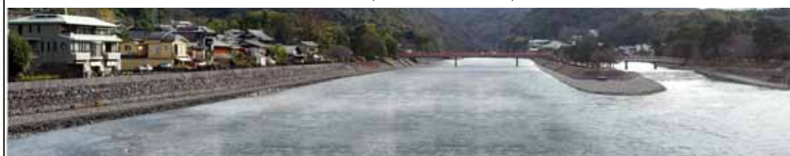
0.3m掘削河道 (流量約 90m 3 /S)
