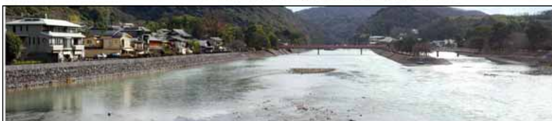
現況河道 (流量約 90m 3 /S)
