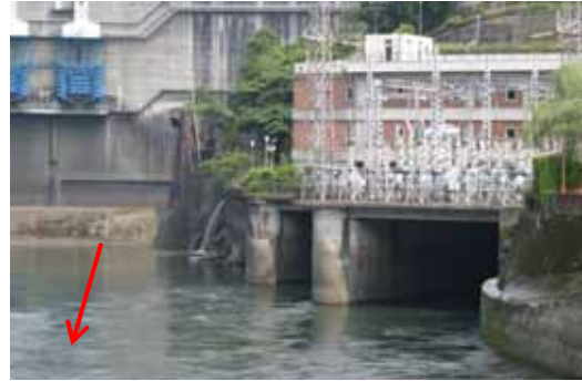
写真 3.9 白虹橋から吐口を望む ダム放流 0\text{m}^3/\text{S} 、発電 100\text{m}^3/\text{S}
