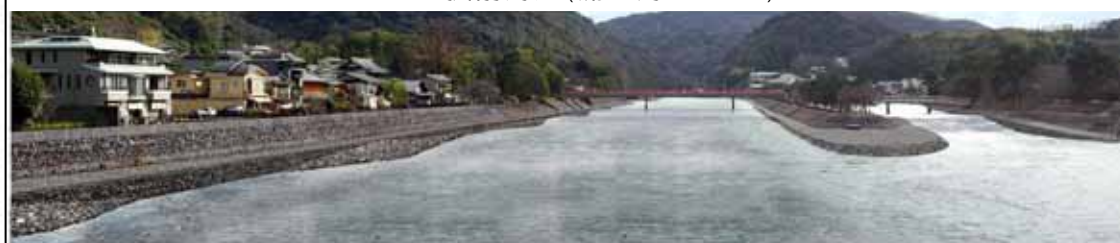
1.1m掘削河道 (流量約 90m 3 /S)
