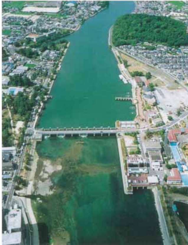
写真 1.4 瀬田川洗堰全景
