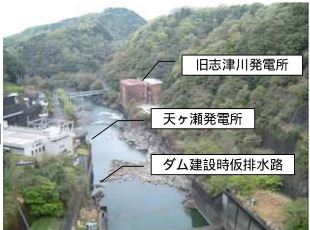
写真 3.7 天ヶ瀬ダムから下流を望む ダム放流 0m 3 /S，発電 30m 3 /S
