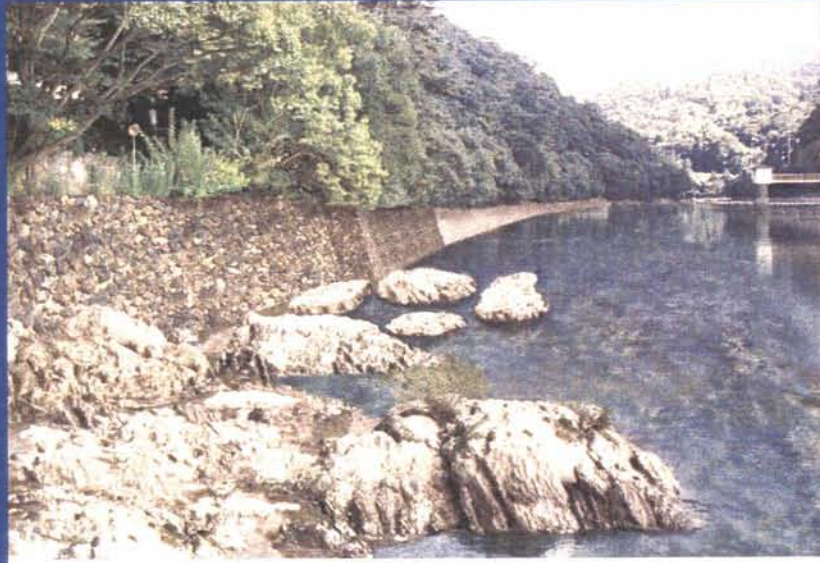
亀石部 0.8m掘削 平水位(約40m 3 /s)
