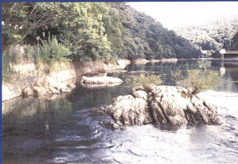
亀石部 現況 平水位
