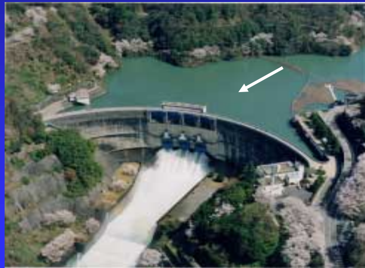
②天ヶ瀬ダム
