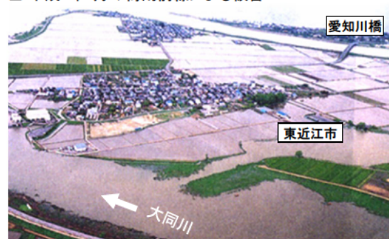
琵琶湖沿岸の浸水被害の様子(滋賀県東近江市付近)
