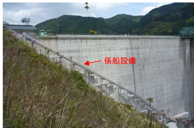
係船設備イメージ(大山ダム)
