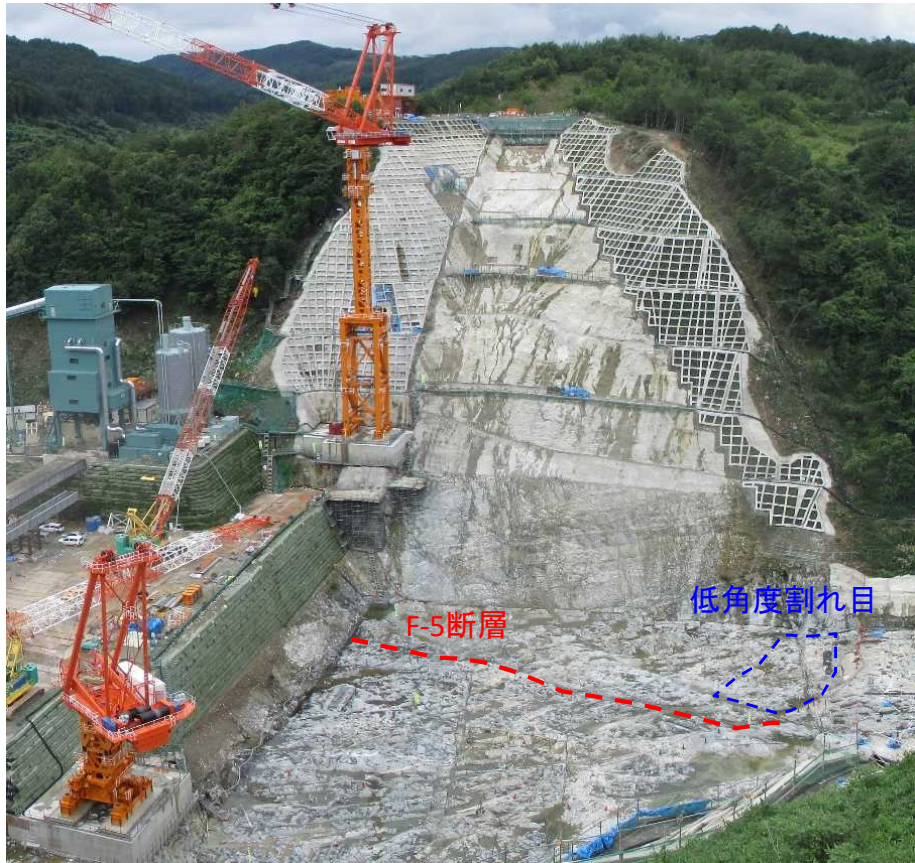
基礎地盤状況(低角度割れ目及び断層位置)
