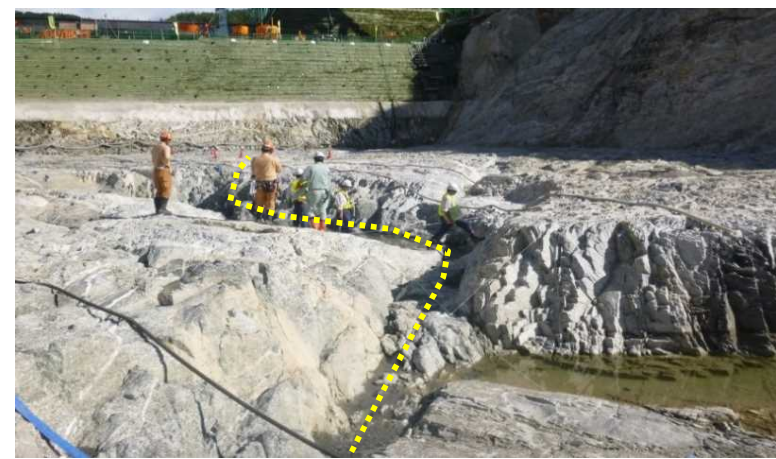
F-5断層(掘削後)
