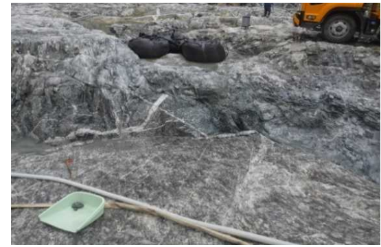
低角度割れ目 掘削後
