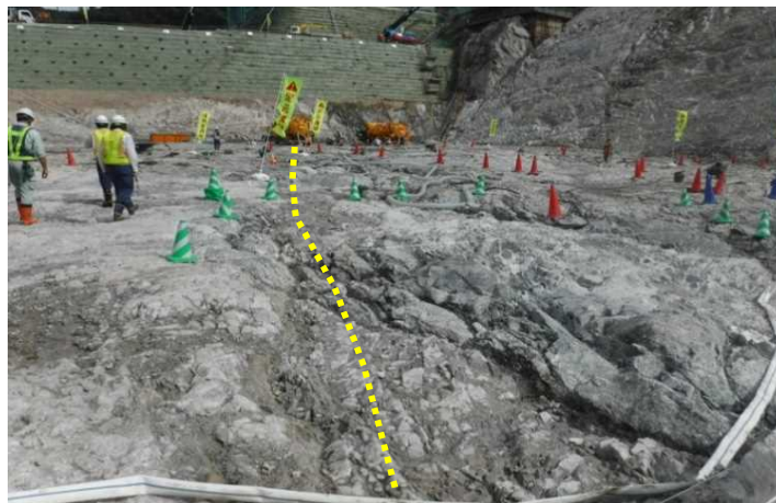
F-5断層(掘削前)
