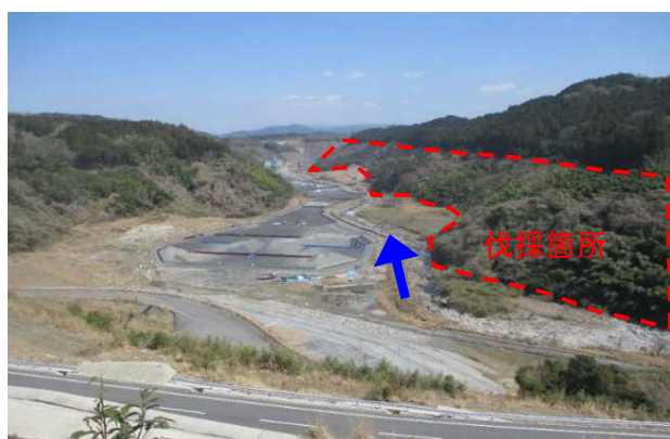
前深瀬川右岸外清掃伐採作業(現地状況)
