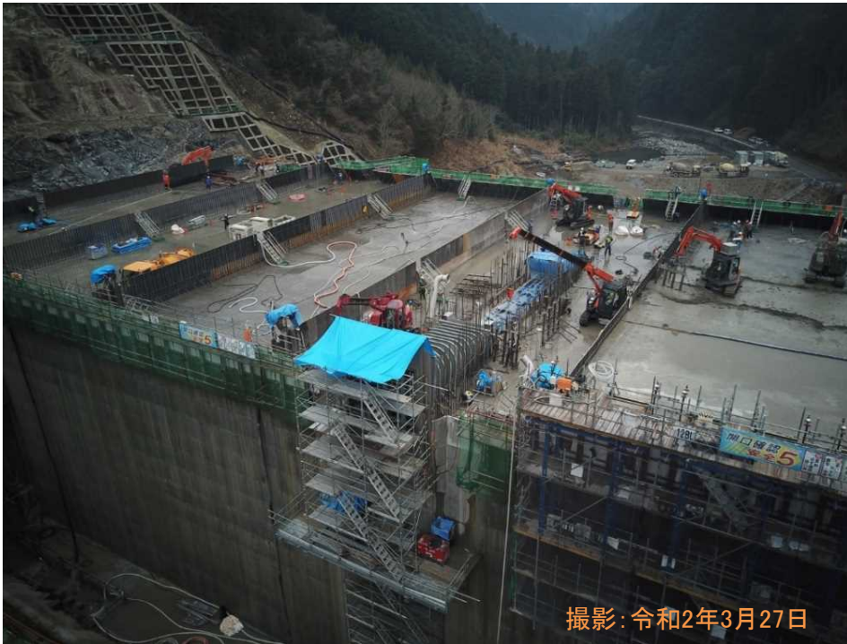
常用洪水吐き放流管設置状況
