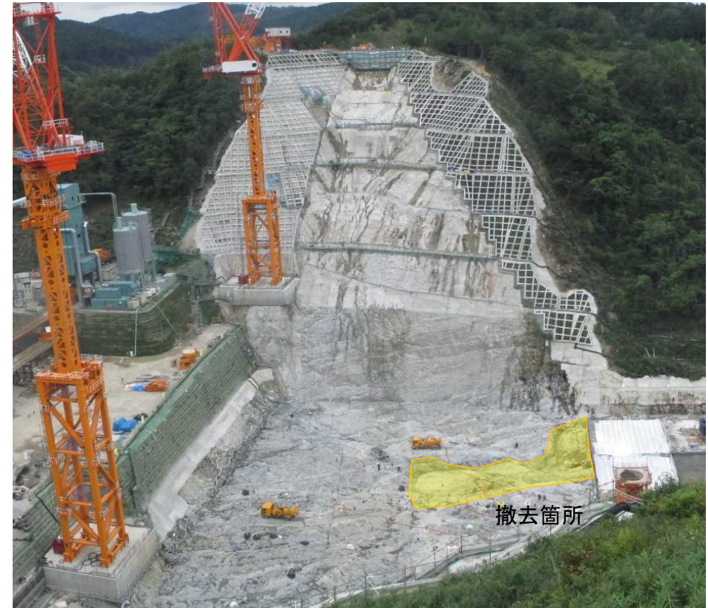
基礎地盤状況(低角度割れ目及び断層撤去後)
