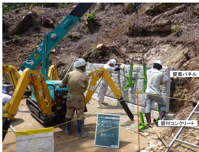
地山の改変量を最小限に抑え、据付コンクリートを打設し、壁面パネルを設置
