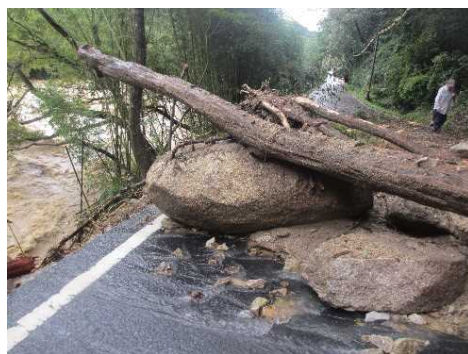
H25台風18号による現道への落石
