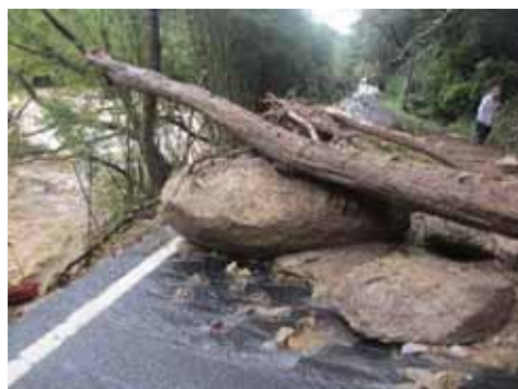
H25台風18号による現道への落石
