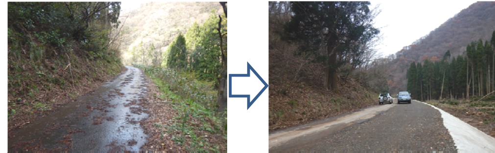
平成29年度 道路復旧状況(鷺見地区)
