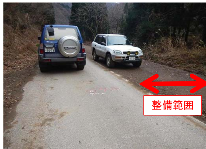
施工後(土工完了)
