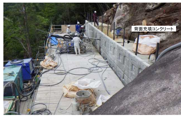
壁面パネルの背後にコンクリートを充填し、アンカーで地山と一体化させる
