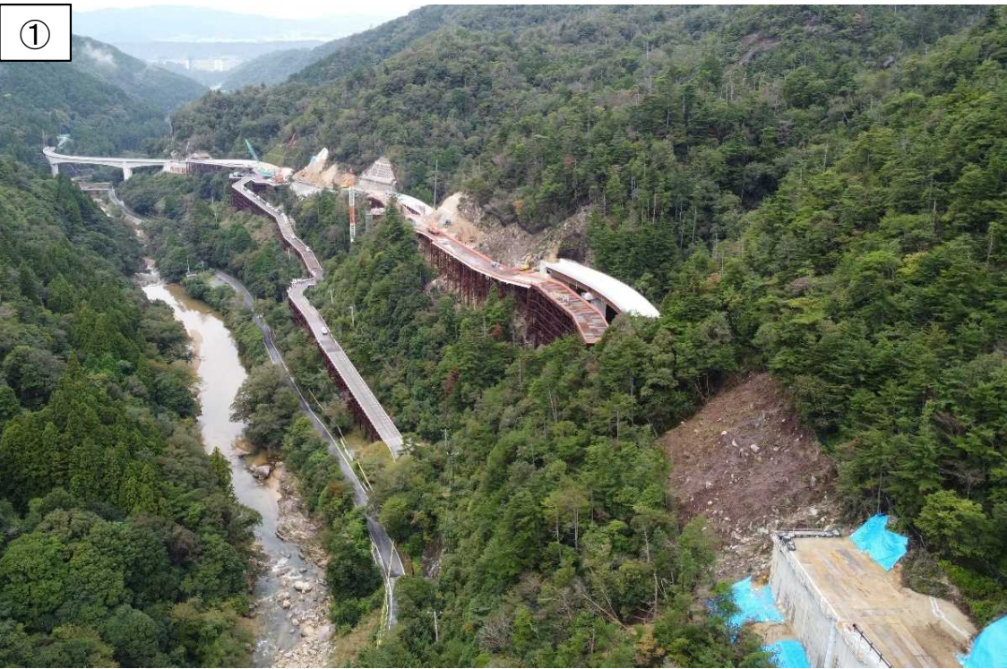
残工事区間全景(令和3年10月時点)
