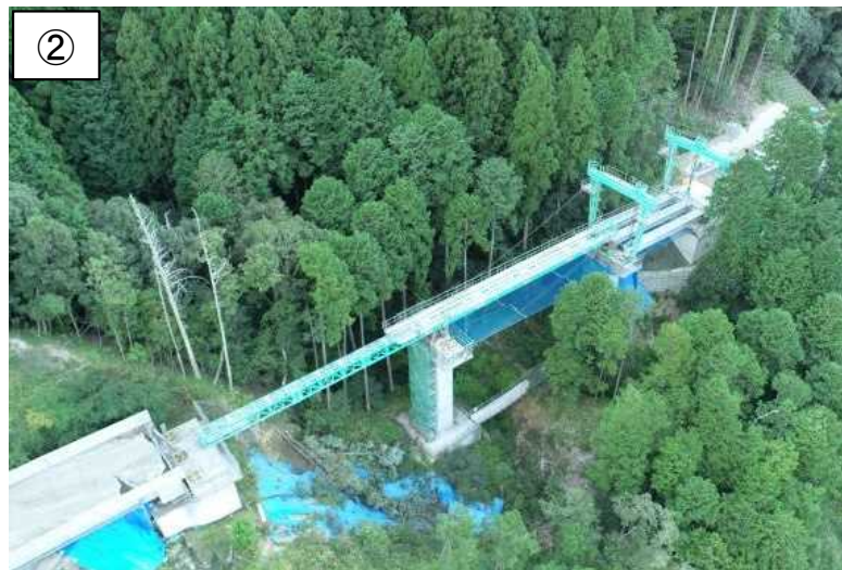
新2号橋上部工事(令和3年10月時点)
