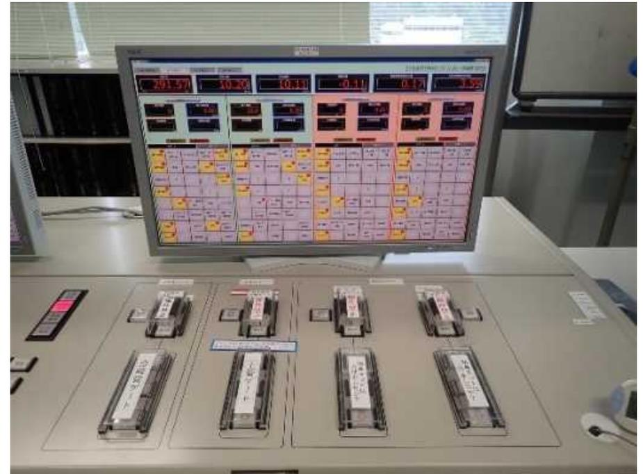
ダム管理用制御処理設備イメージ(比奈知ダム)
