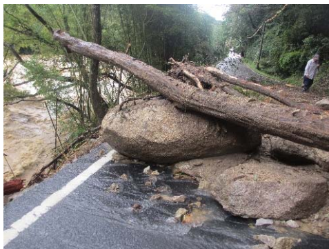
H25台風18号による現道への落石
