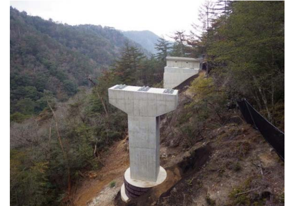
施工中の付替県道大津信楽線 新8号橋
