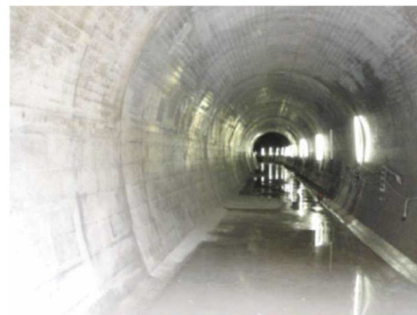
仮排水路内部施工状況 (他ダム事例)
