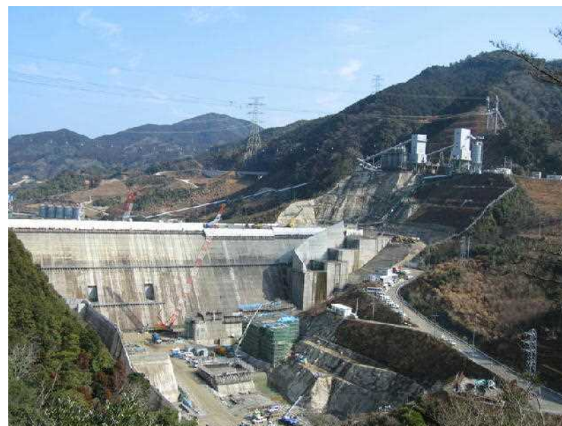
堤体工（他ダム事例）
