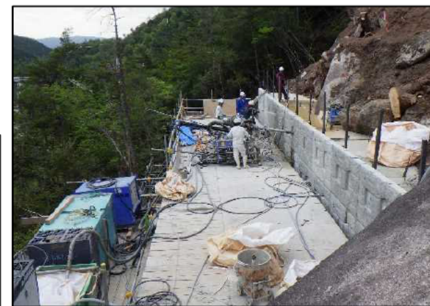
補強土壁の設置状況
