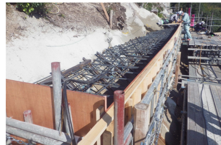
アンカー上部に鉄筋Coを施工し、ルートパイル基礎部分を構築。
