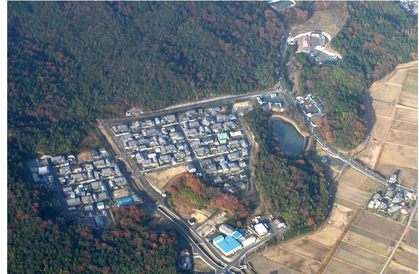
水没家屋の集団移転状況
