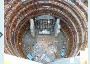
所定の位置へセット、仮固定してワイヤロープを外します。
