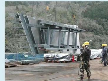
ブロックの重量は、約 5000kg (関取 40 人ぐらいです) 地上から 50m 下の立坑内部に吊り下ろします。
