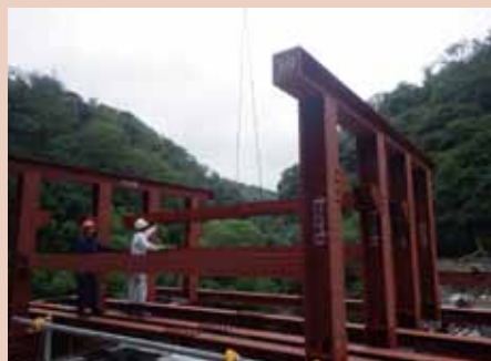
② 内部支保工地組
