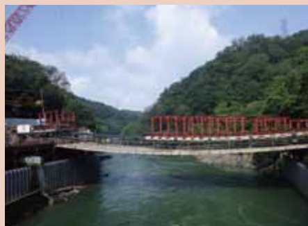
③ ユニットブロック引出し架設
