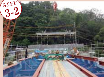
① プレキャスト床版架設
