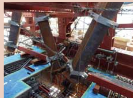
② 鋼斜材架設
