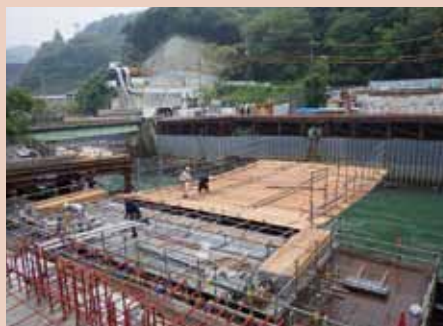
② 吊り足場設置
