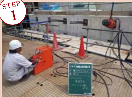
① グランドアンカーの緊張(鉛直・1段目)
