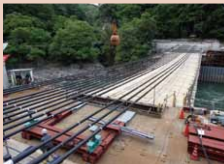
③ 一次ケーブル架設
