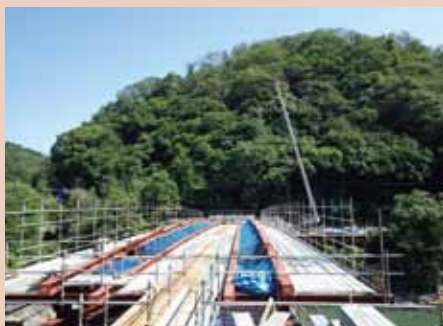
② 内部支保工足場、軌道敷設
