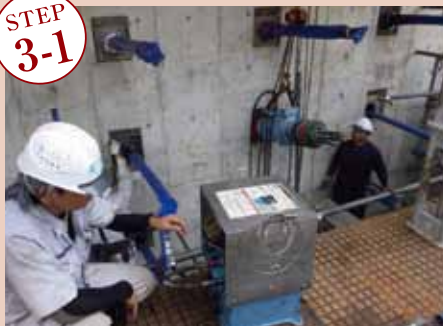
① グランドアンカーの緊張(2・3段目)
