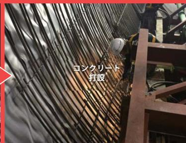
4 コンクリートを流し込んで固め、トンネルの壁をつくります。
