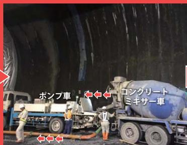
3 コンクリートを、トンネルの壁をつくるところでまで、ポンプで送り込みます。
