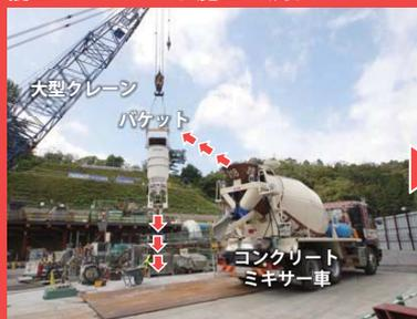
1 コンクリートミキサー車で、工事現場にコンクリート運びます。
