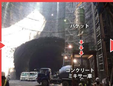
2 コンクリートを運ぶバケット（大きなバケツ）を大型クレーンで地上から地下に降ろします。
