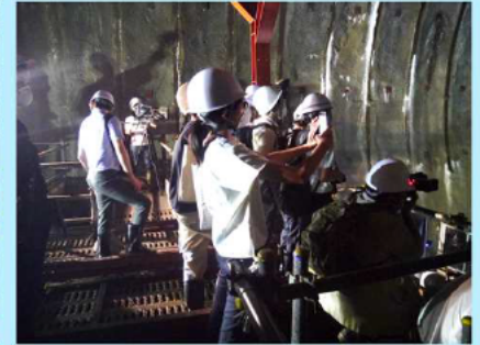
貫通の瞬間を撮影している状況です。
