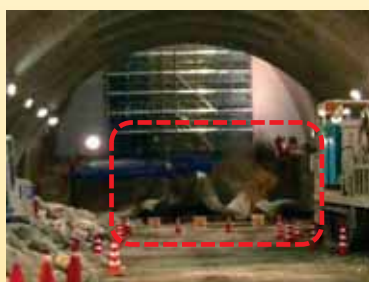
発破の瞬間です。「重し」が爆破で浮き上がっています。
