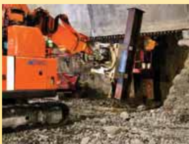
鉄骨を建込み、トンネルを支える骨組みを設置します。
