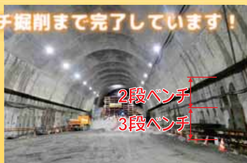
バックホウで集積しダンプトラックで、ずり(岩石)を運び出します。
