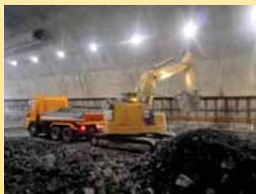
バックホウで集積しダンプトラックで、ずり(岩石)を運び出します。
