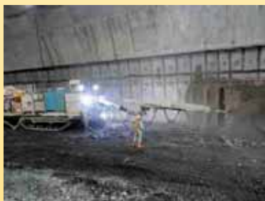
壁面にすぐに固まるコンクリートを吹付けて、トンネルを補強します。
