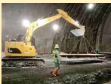
爆破の影響で岩の飛散を抑えるための「重し」を並べます。
