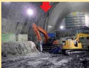
発破によって生じたずり(岩石)を大型ブレーカで更に破碎します。
