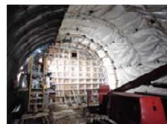
側壁導坑内コンクリート打設
