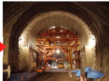
水平水路部コンクリート打設
