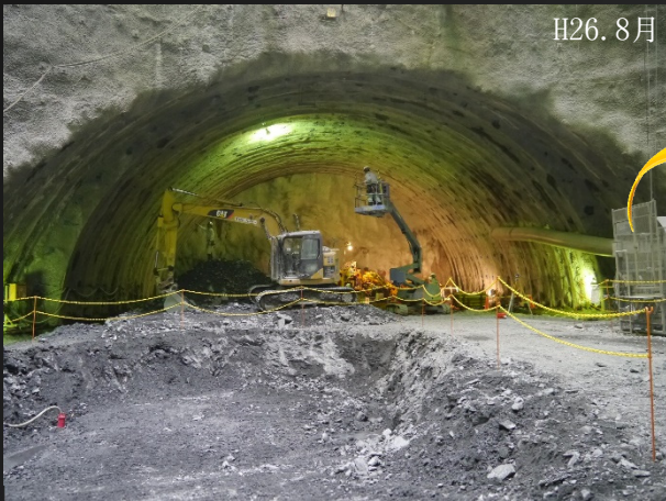
ゲート室部から建設機械を入れ、上半部より掘り始めました
