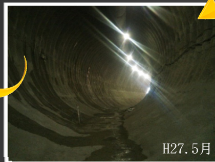
下半掘削後、吹付コンクリートの施工が終わり、掘削が完了しました
