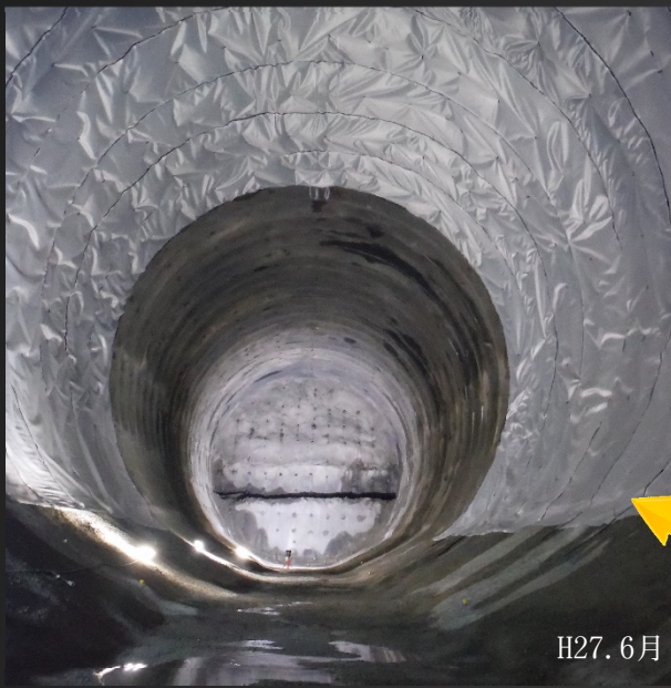
シートを貼り、覆工コンクリートを施工する準備を行っています
