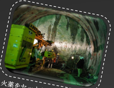
火薬をセットし、発破の準備をしています
