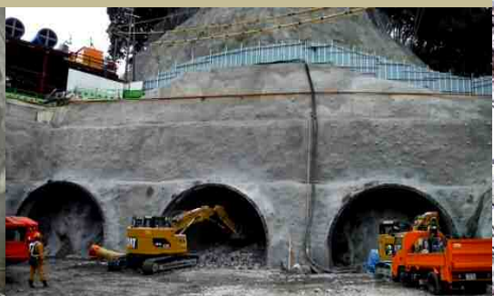
■減勢池部 平成27年3月撮影 減勢池部のトンネル掘削を始めました。
