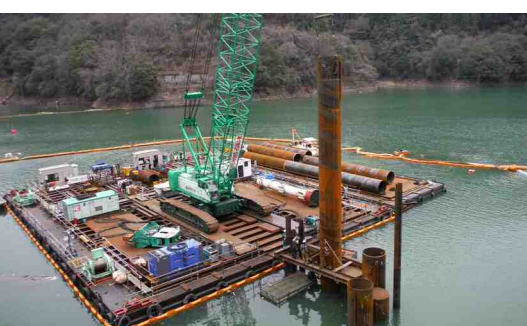
■流入部 平成27年3月撮影 鋼管を打ち込んでいます。
