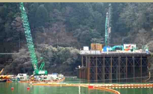
■流入部 平成27年3月撮影 鋼管を打込み、止水のための壁を作っています。
