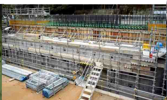
■新白虹橋（仮称） 平成27年3月撮影 橋台（パラペット）を作っています。
