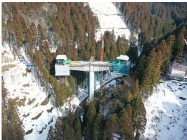
足羽川ダム付替県道 3号橋上部工事
