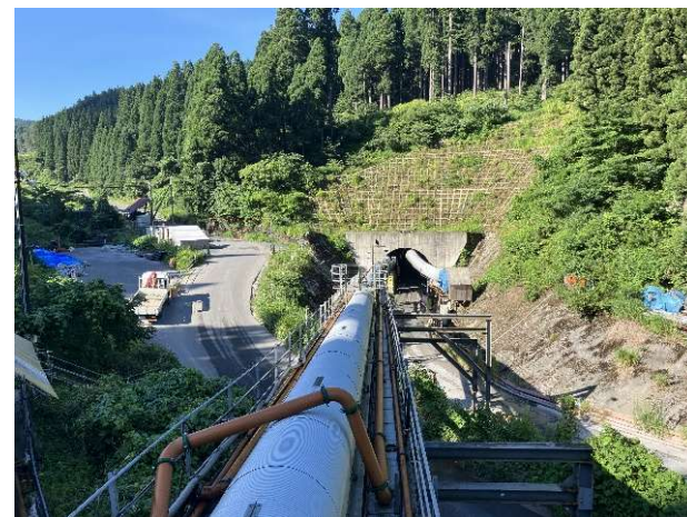
水海川導水トンネル3期工事
