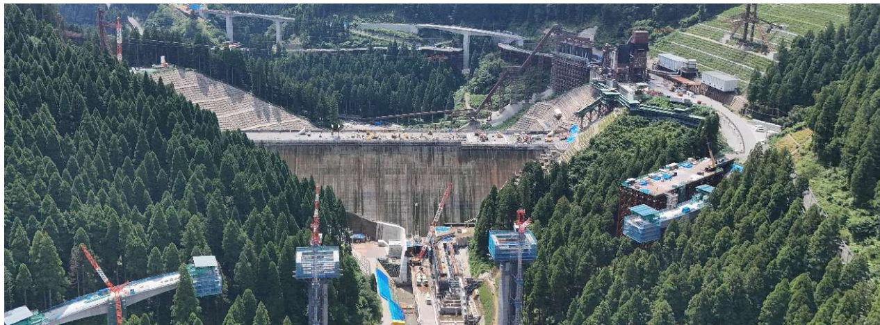
足羽川ダム本体建設(第2期)工事
