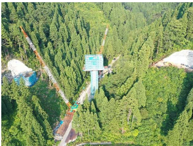
足羽川ダム付替県道 3号橋上部工事
