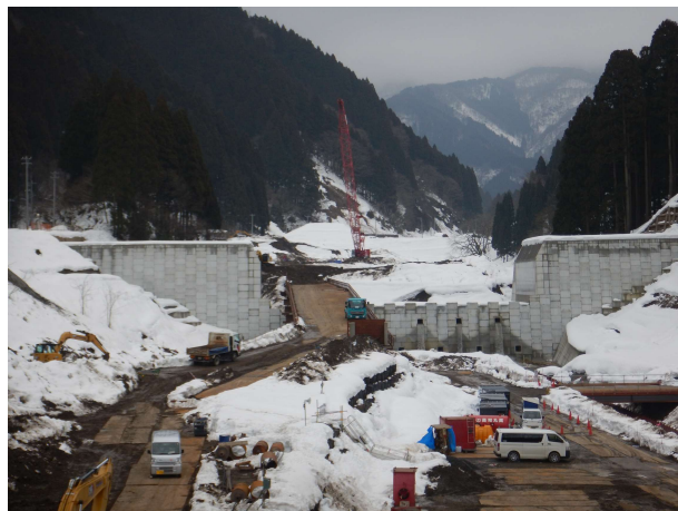
足羽川ダム水海川貯砂ダム工事
