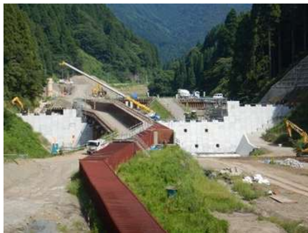
足羽川ダム水海川貯砂ダム工事
