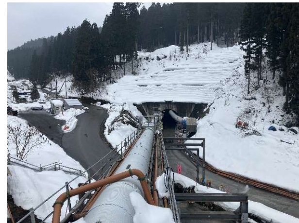
水海川導水トンネル3期工事
