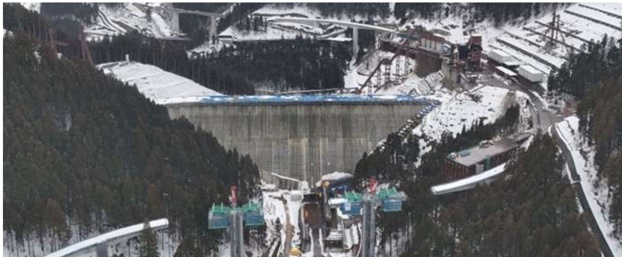
足羽川ダム本体建設(第2期)工事
