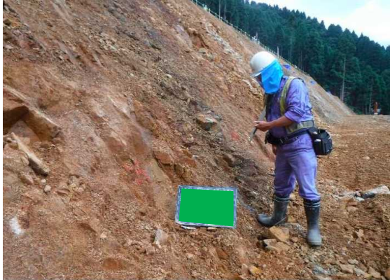
地質調査実施状況
