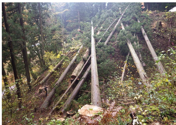
工事用道路施工箇所
