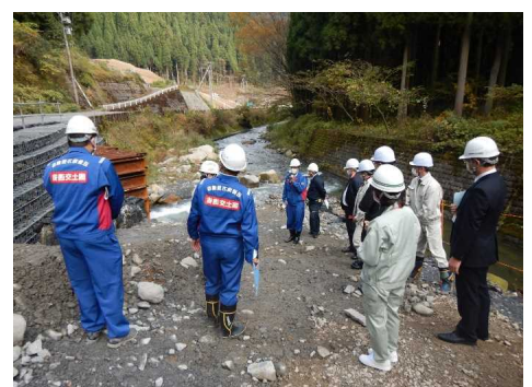
転流状況の確認
